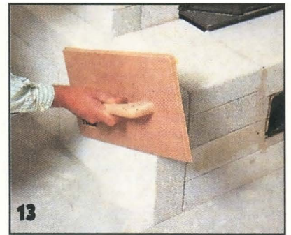
13 Когда клей высохнет, грубой теркой разглаживают неровности и снимают фаски на углах.
