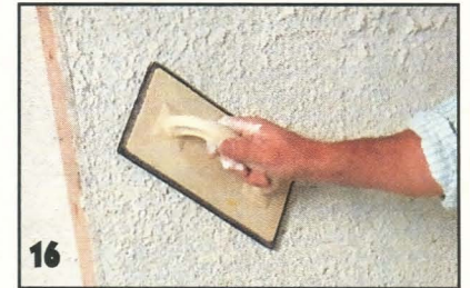
16 Когда штукатурка подсохнет (приблизительно через 10 мин), ее поверхности можно придать желаемую структуру.
